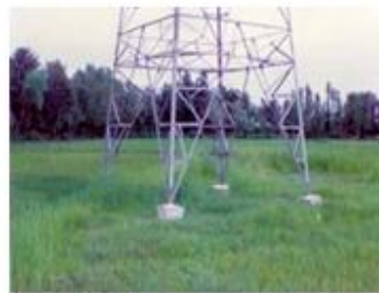
مراحل ساخت و استقرار پایه های دکل برق در شالیزار
