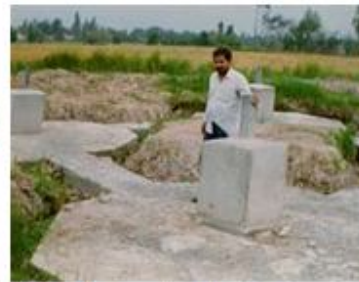
مراحل ساخت و استقرار پایه های دکل برق در شالیزار
